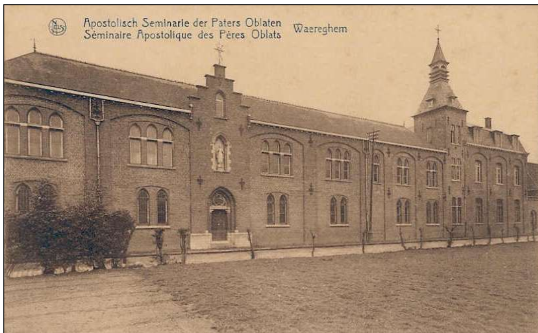
de gesloopte vleugel aan de straatkant van het "Apostolisch Seminarie der Paters Oblaten" Bemerk dat de overkant van de Olmstraat nog niet bebouwd was. Daar staat nu het H.-Hartcollege.
